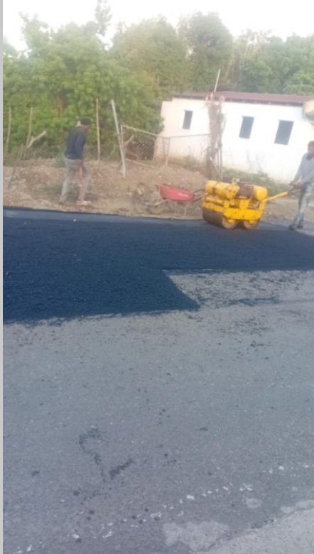
Bacheo Palo amarillo y monte de la Zanja
