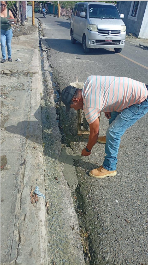
Reparación de contenes en la comunidad de La Zanja
